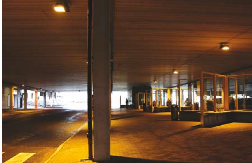
Bussterminalen har ei god plassering, men framstår som utrygg og lite tiltalende. Foto: HJR
