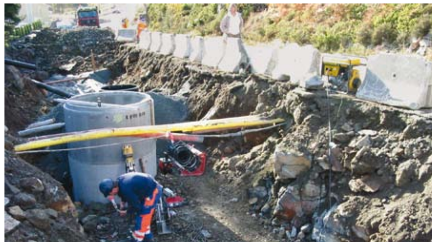
Arbeidet til grøfteetatane må koordinerast. Foto: FjellVAR AS
